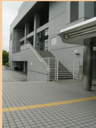
＜階段～エントランス＞
